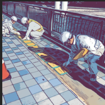
3. プレート設置
