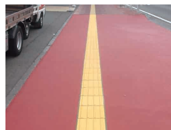
⑧ テープを除去し、硬化したら完成
