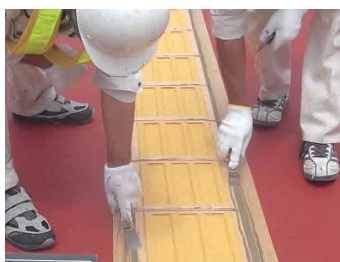
⑤ プレート外側目地と、つなぎ目地の接着剤をヘラで仕上げ
