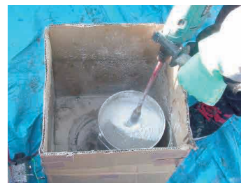
② 主剤に骨材、規定量硬化剤を投入し、ミキサーでよく混合
