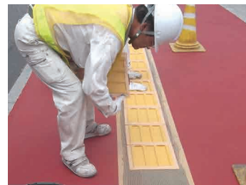
④ プレート裏面にエアたまりができないようにプレートを圧着
